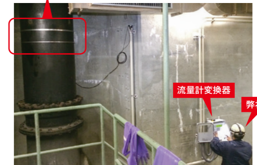
某終末処理場 初沈汚水ライン (口径: 1000A)
