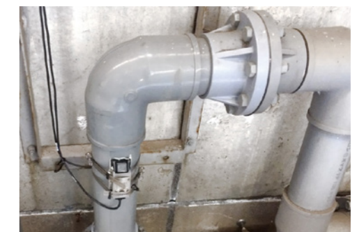
某水族館 海水ライン (口径: 65A)
