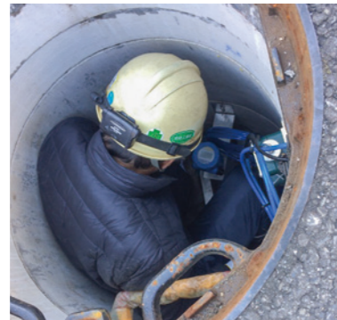
水路点検/清掃及び 流速・水位センサーの点検
