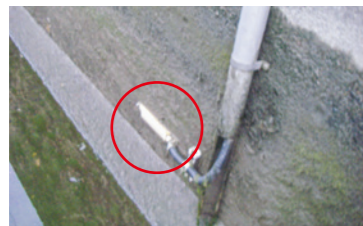
農業用水路(取水工) 水路底に体積物が溜まるので水路壁に流速センサーを取り付け
