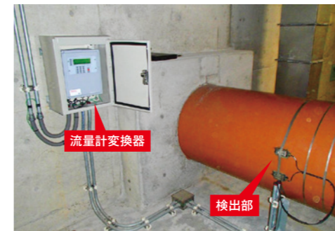
某下水処理場 初沈流入ライン (口径: 800A)
