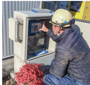
流量計変換器 点検/調整の様子
