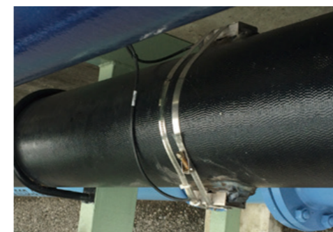
某水再生センター 汚泥送泥ライン (口径: 200A)
